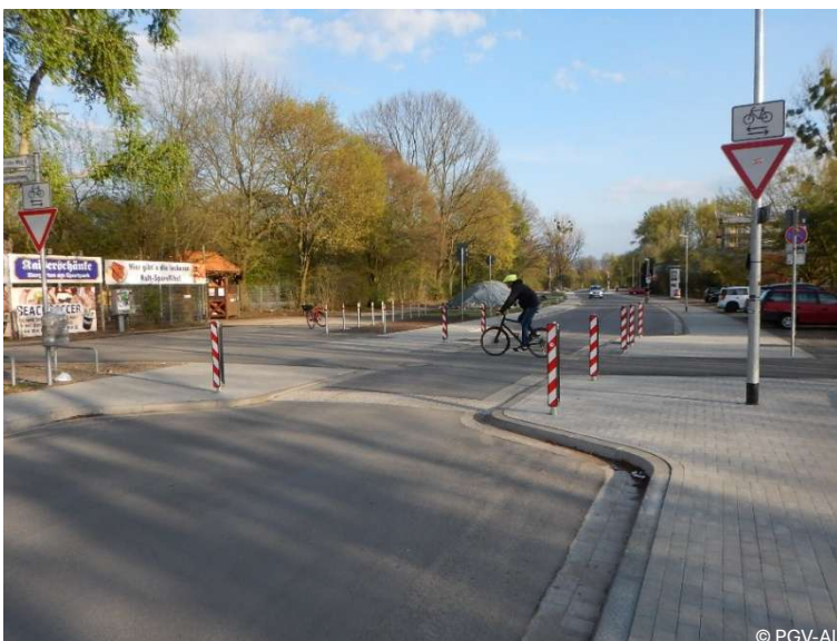
Abbildung 26: Betonung des Vorrangs der Radverkehrsverbindung durch deutliche Fahrbahneinengung und Aufpflasterung.
