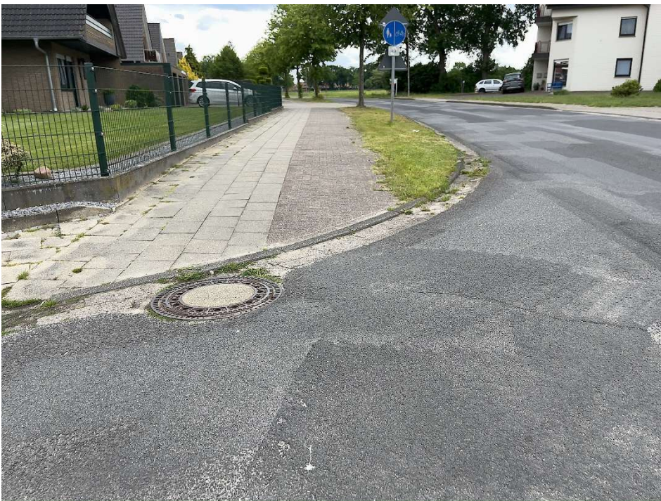
Abbildung 34: Vorbildliche Führung: Getrennter Geh- und Radweg, Pflasterbelag, ausreichend breit, klar von der Fahrbahn getrennt (Beispiel: Industriestraße, Ortsteil Herzlake)
