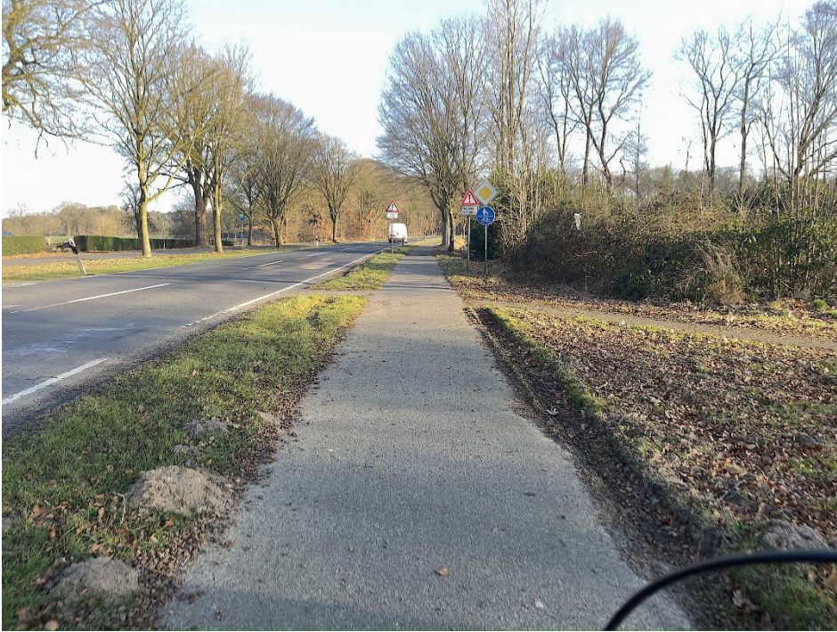
Abbildung 35: Typisches Beispiel: Gemeinsamer Geh- und Radweg, asphaltiert und 1,85m breit (Beispiel: Lastruper Str., Ortsteil Lastrup)
