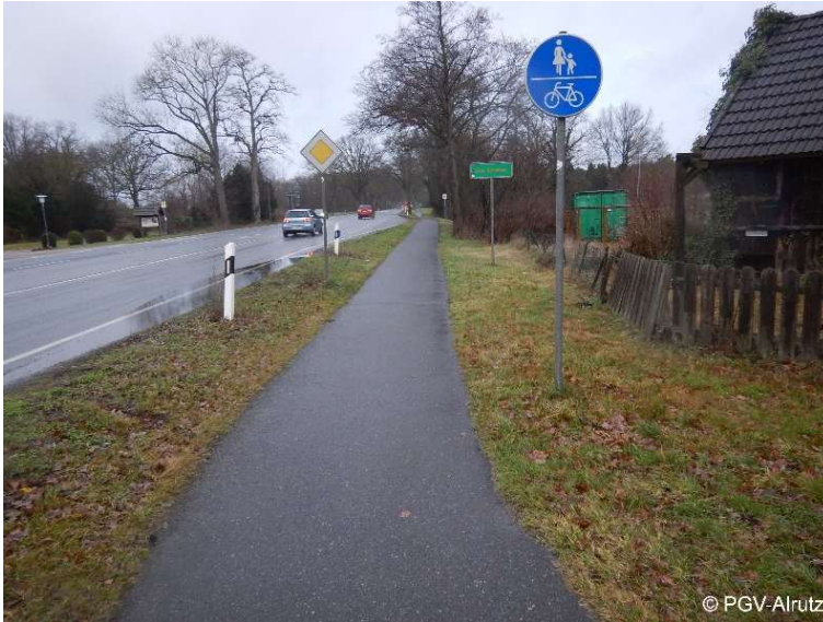
Abbildung 11: Gemeinsamer Geh- und Radweg außerorts.
