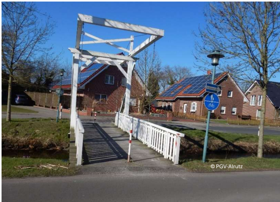
Abbildung 28: Kleine Gewässerbrücke mit ortsbildprägender Gestaltung.
