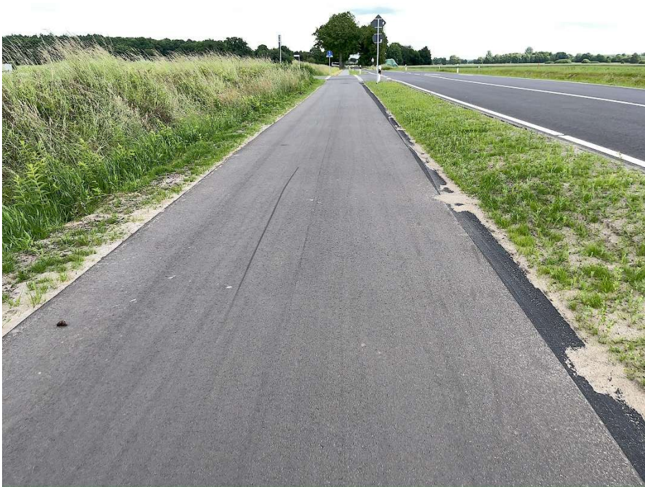
Abbildung 37: Vorbildlich: Gemeinsamer Geh- und Radweg, asphaltiert, 2,5m breit, klar von der Fahrbahn getrennt (Beispiel: Moorstraße, Ortsteil Dohren)
