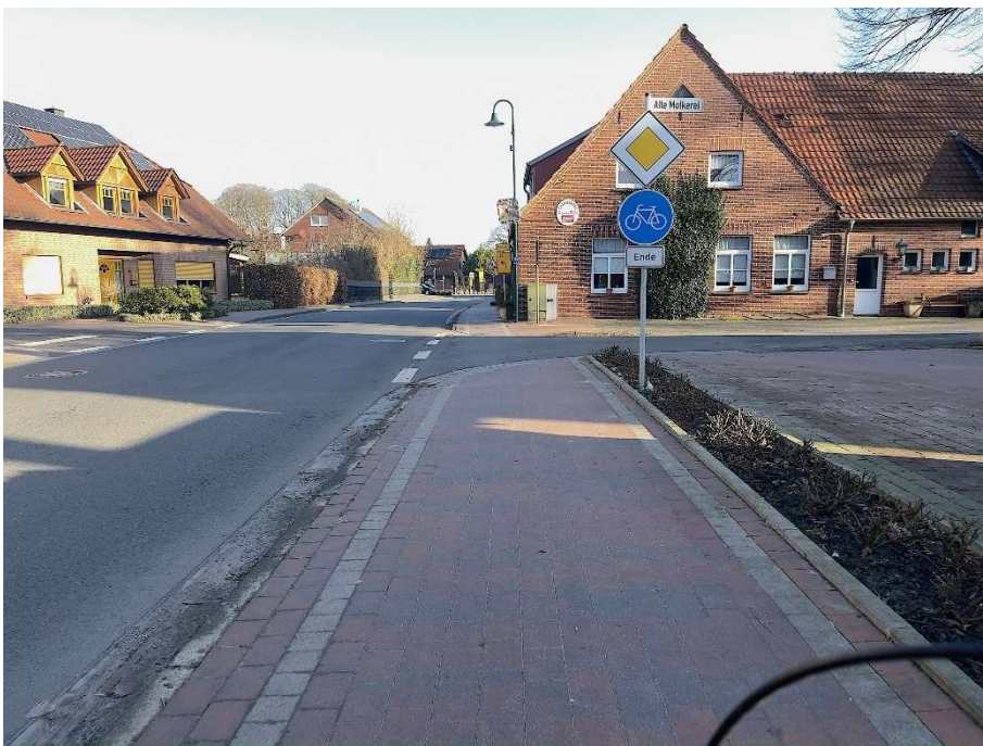
Abbildung 30: Verbesserungswürdig: Radverkehrsführung endet abrupt, Radfahrende auf die Straße ohne Wegeführung, Maskierung oder Fahrstreifen (Beispiel: Holter Hauptstraße, Ortsteil Holte)
