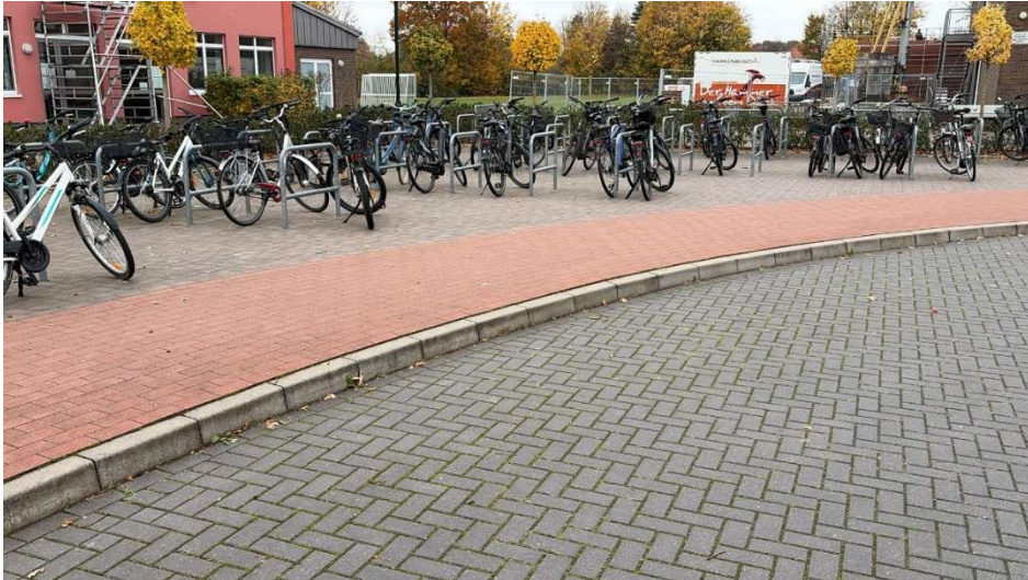
Abbildung 46: Vorbildlicher: Radabstellanlage mit Doppelholm Anlegebügel und fester Standfläche aber ohne Witterungsschutz. (Beispiel: Schulzentrum Herzlake, Ortsteil Herzlake).
