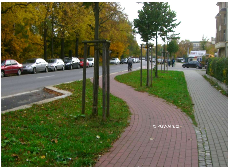
Abbildung 22: Heranführen eines Radwegs an die Vorfahrtstraße, um die Sichtbeziehungen zwischen rechtsabbiegenden Kfz und Radverkehr zu verbessern.
