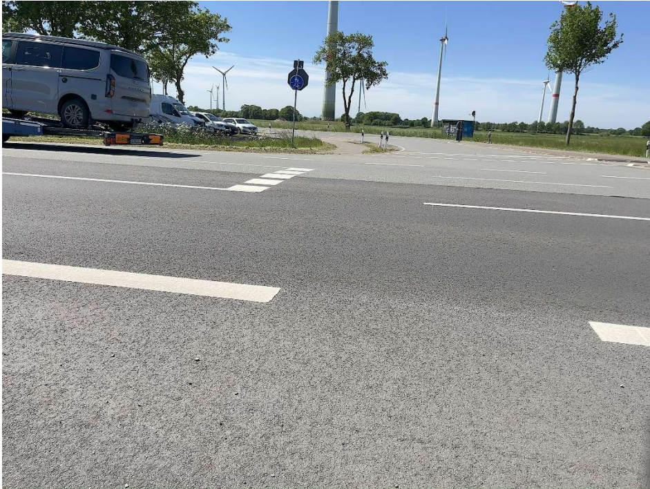
Abbildung 39: Kritisch: Querungsstelle an Bundesstraße ohne Markierung, Ampel oder bauliche Radverkehrsführung (Beispiel: B402, Ortsteil Dohren).
