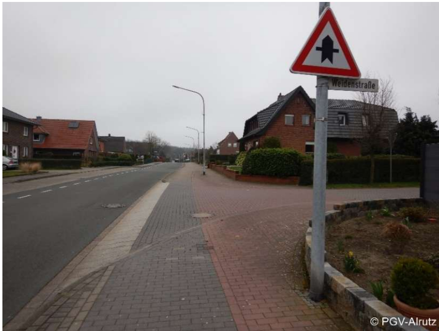
Abbildung 21: Rad- und Gehwegüberfahrt mit Rampenstein.
