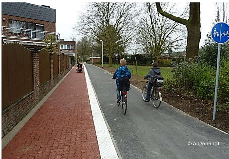
Abbildung 18: Getrennter Geh- und Radweg. Trennung der Verkehrsarten durch einen taktil erfassbaren Trennstreifen.
