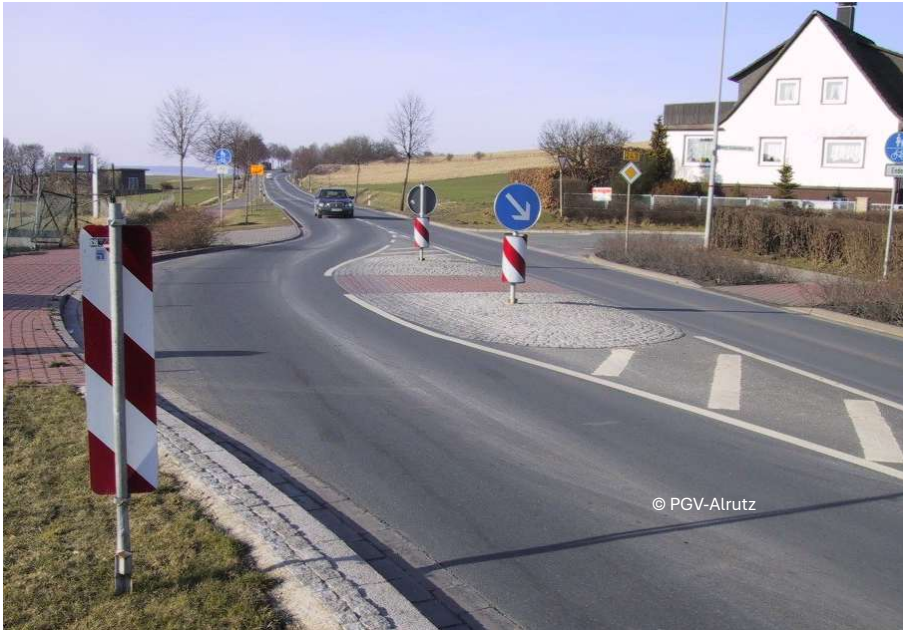
Abbildung 27: Mittelinsel im Zuge einer Radverkehrsverbindung.
