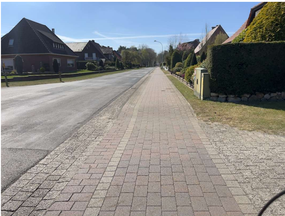
Abbildung 32: Typisches Beispiel: Gemeinsamer Geh- und Radweg, Pflasterbelag, zu schmal für Begegnungsverkehr (Beispiel: Kolpingstraße, Ortsteil Lähden).
